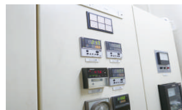
於儀器訊號的測量值上顯示% 4-20 mA / 0-20 mA %換算顯示
