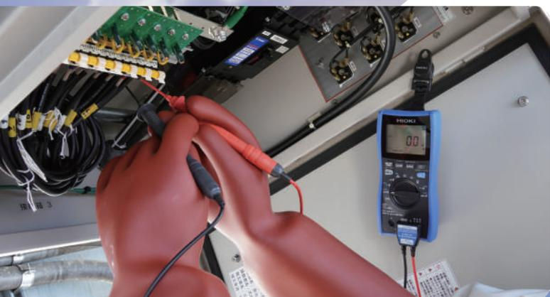
現今1500V的太陽能發電設備日漸普及，能夠對應高電壓的測量儀器的需求也日漸提升。考慮到今後的設備也會日漸高電壓化，HIOKI也開發了符合CAT III 2000 V規格的直流高壓探棒 P2010。
